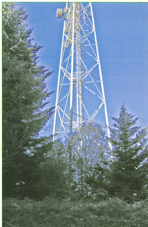
Pylône en cours d'intégration
