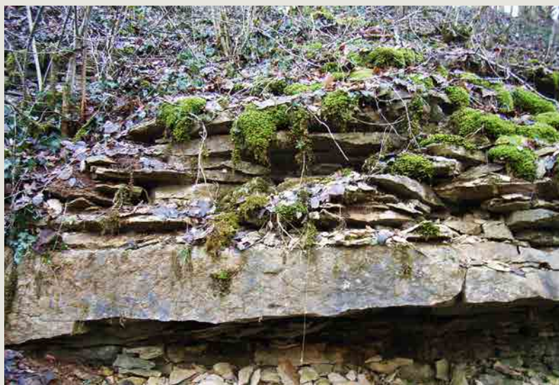
Plaquette calcaire sur dalle compacte.
